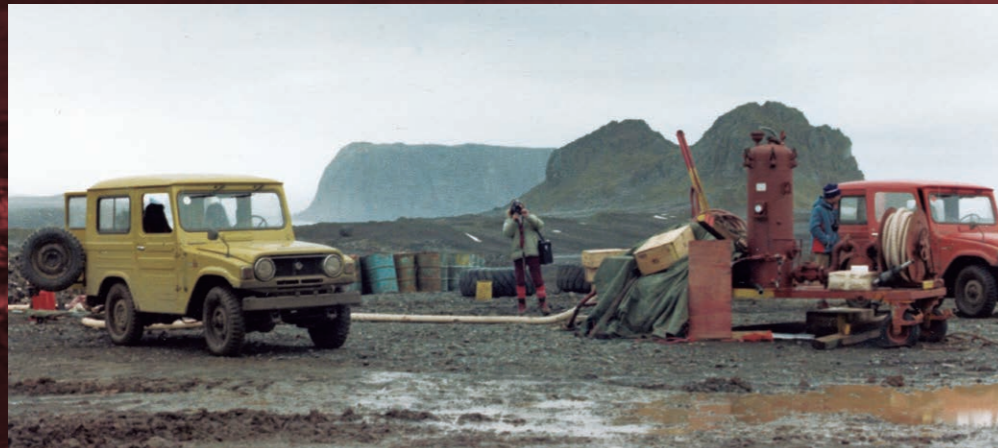
Trabajo de construcción de la pista.
