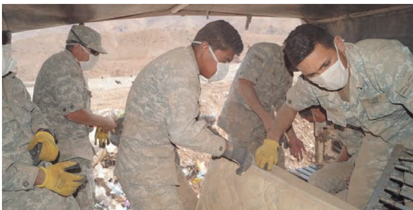
Personal de la Vª Brigada trabaja en la remoción de escombros.
