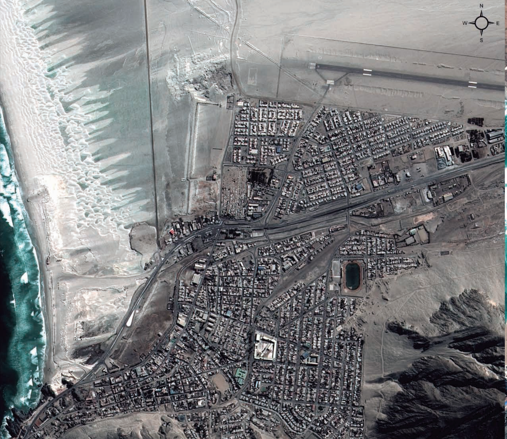
Las imágenes en páginas 30 y 31 muestran la localidad de Chañaral antes y después del destructivo aluvión y la crecida del río Salado.
