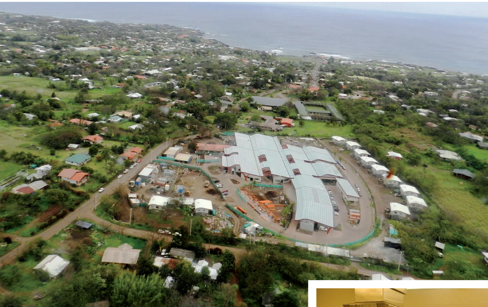
Arriba: Fotografía aérea del Hospital Hanga Roa.
