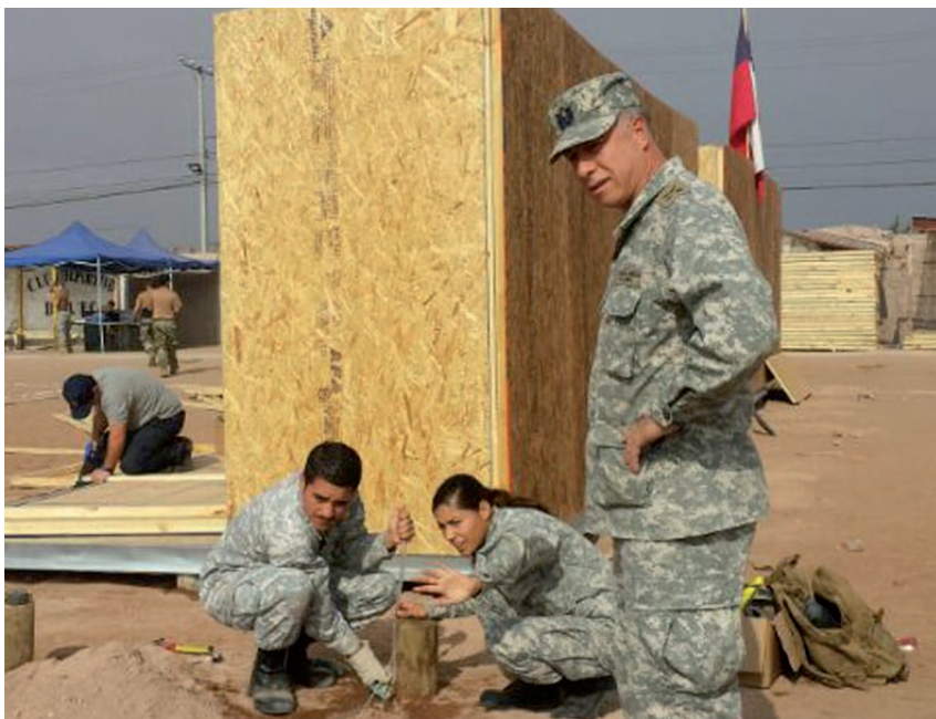
El General Ibacache inspecciona la instalación de viviendas para los damnificados de Alto Hospicio.
