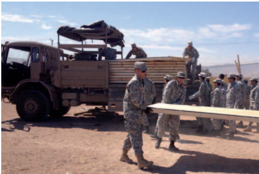
Descarga de material para las viviendas de emergencia.
