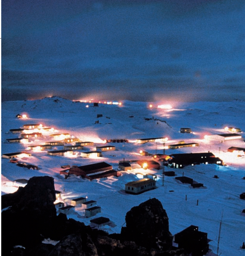
Vista panorámica de la Villa Las Estrellas y la Base Aérea Presidente Frei.
