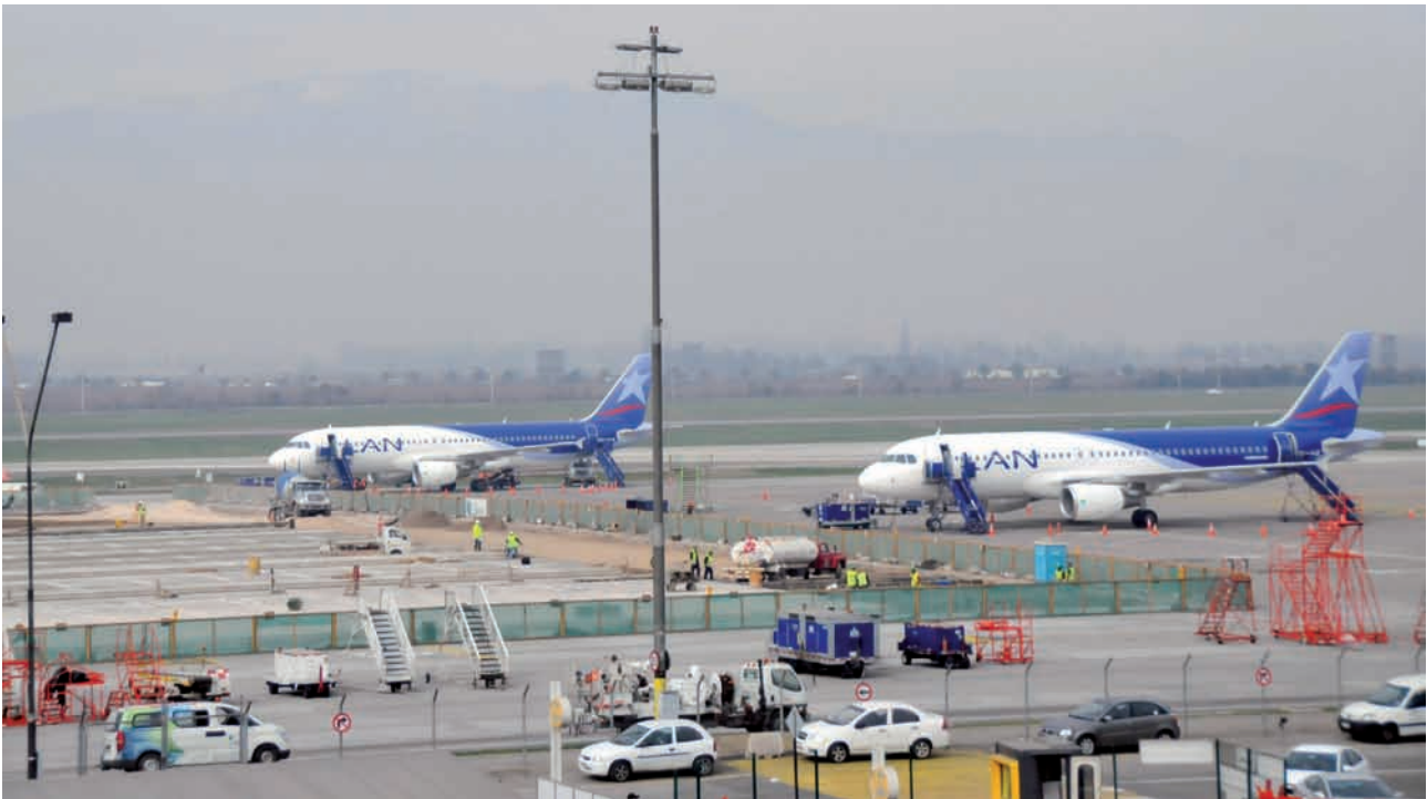
La primera fase de ampliación del aeropuerto considera la renovación de 57 mil metros cuadrados de pavimentos.
