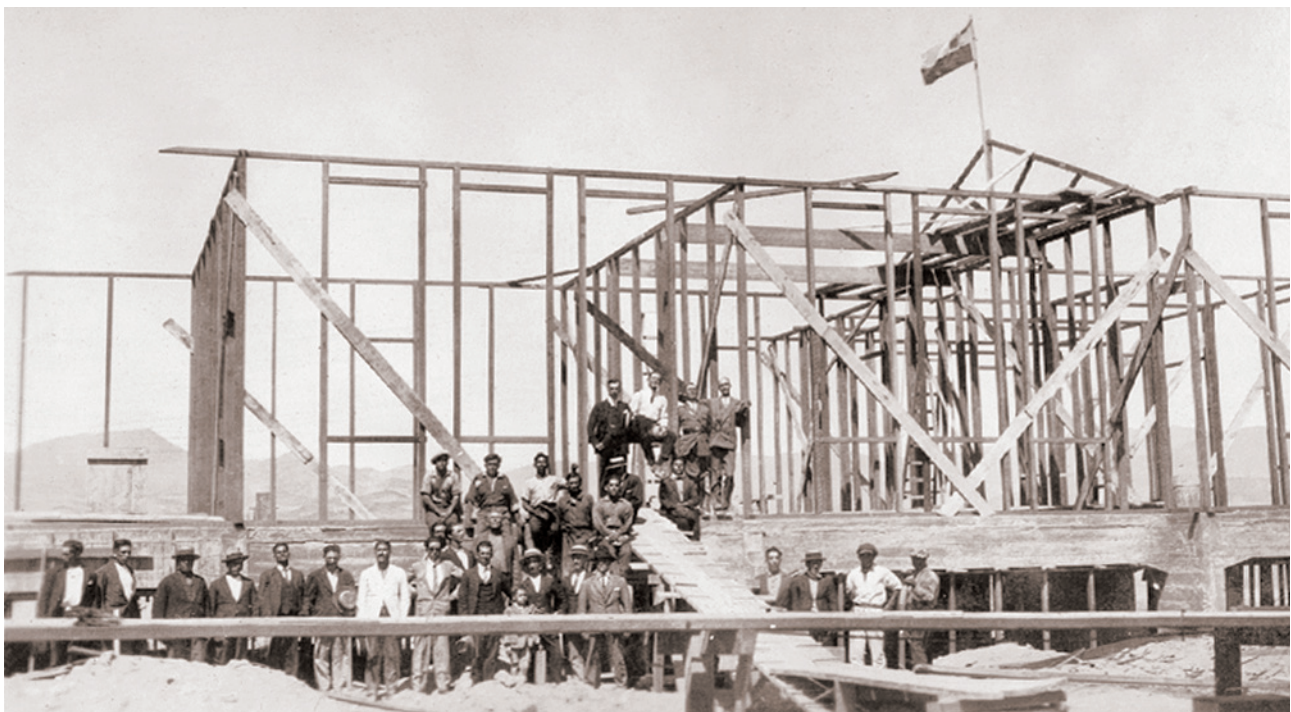
Una gran cantidad de obreros participó de la construcción de las instalaciones del Grupo de Aviación N° 1 en Alto Hospicio.
