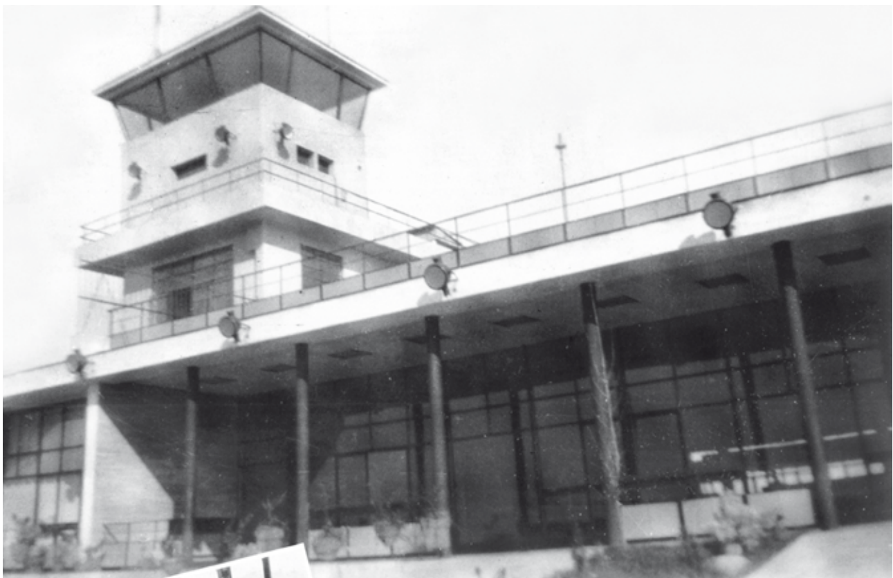
La antena multicanal quedó instalada al tope de la torre en el ala sur del edificio del aeropuerto.
