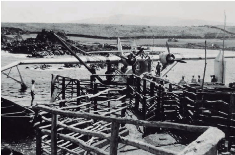
El “Manu-tara” en ensenada Hanga Piko, en donde la tripulación y el personal de mantenimiento le retirarían los motores y equipamiento para su preservación. Se observa el daño de la punta del ala derecha. (MNAE)
